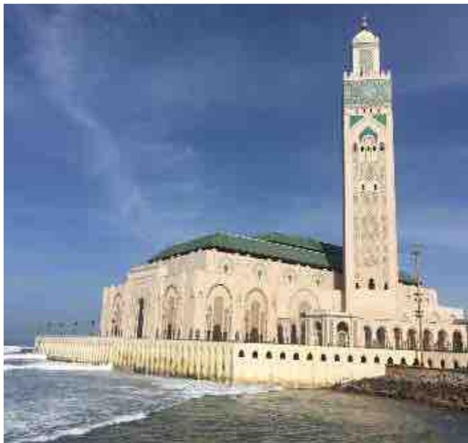
par 1.500 artistes sur plus de 67.000 m<sup>2</sup>. Les coupoles en bois ont été fixées sur des charpentes réalisées avec 971 t d'acier inoxydable et suspendues à la structure en béton armé.
